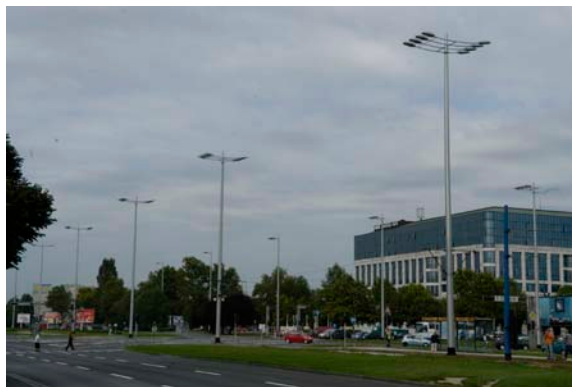
Nova rasvjeta na Aveniji Dubrovnik
